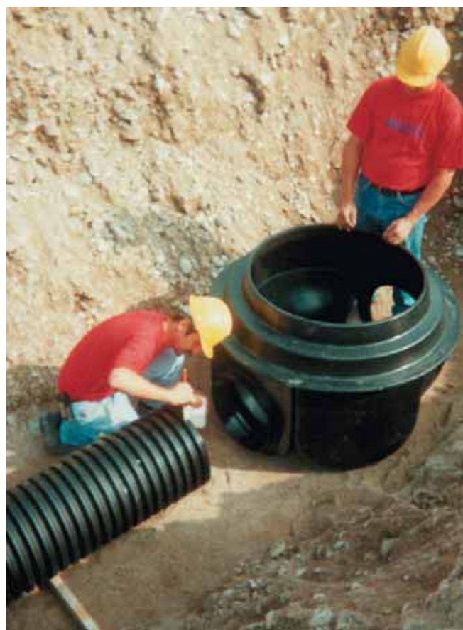
Рис. 19. Соединение лотка ПЭ колодца с трубой
