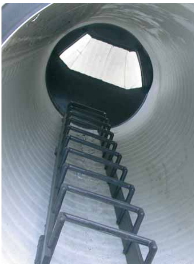
По желанию заказчика в колодце устанавливается лестница с противоскользящим покрытием
