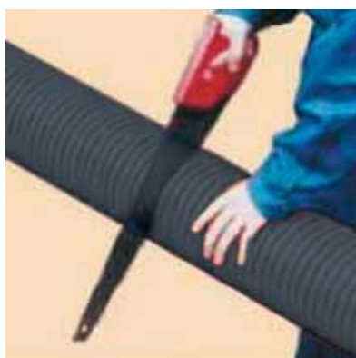
Рис. 14. Резка трубы КОРСИС
