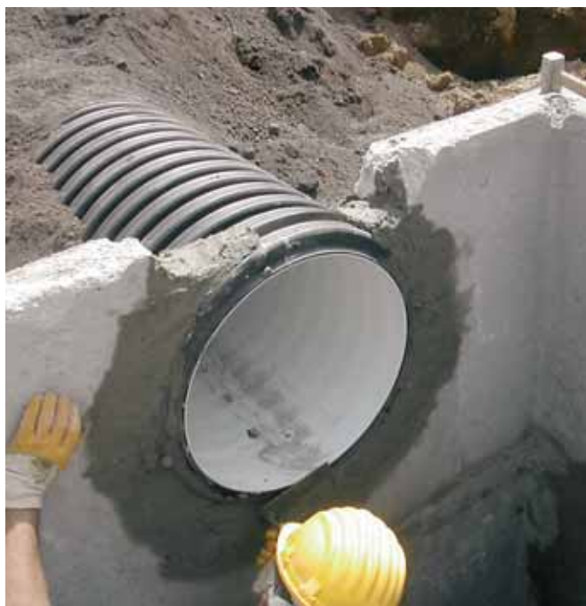
Рис. 20. Монтаж трубы КОРСИС в стенку бетонной камеры
